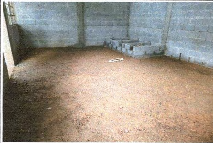
Foto1: Inicio de mejoramiento de piso al módulo de cocina.
