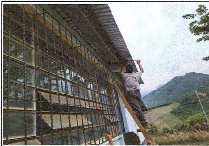
Foto 2: avance en mejoramiento de Canales
