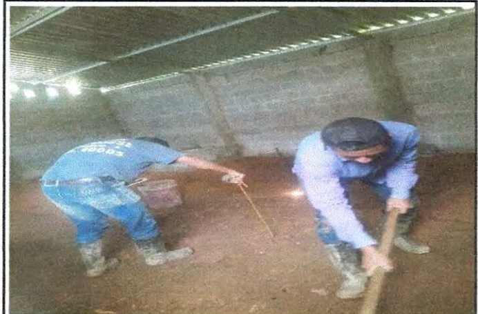
Foto 2: avance en mejoramiento de piso al Modulo de cocina.
