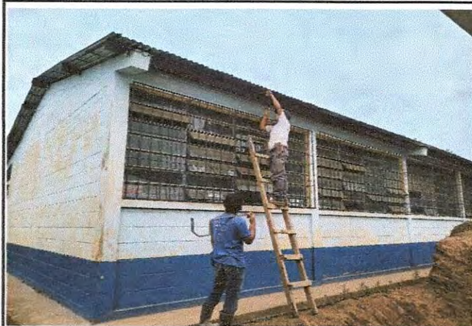
Foto 1: Inicio de mejoramiento de canales y bajada de agua pluvial.
