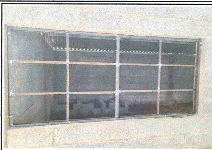
Foto 2: avance en melhoramento de janela al módulo de cozinha.
