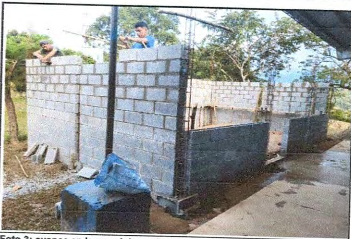
Foto 3: avance en la pared de cocina.
