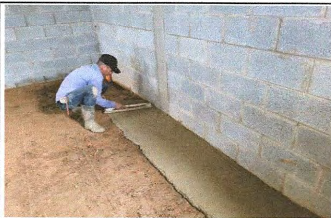
Foto 3: Inicio de colocación de piso de concreto al módulo de cocina.
