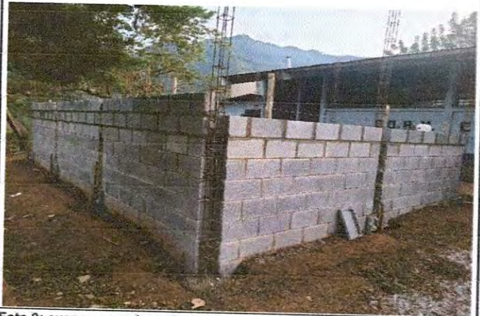
Foto 2: avance en mejoramiento de pared
