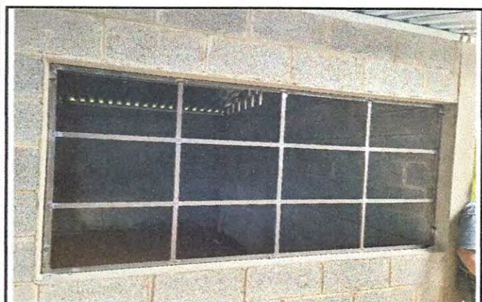
Foto 3: avance en colocación de ventanas al módulo de cozinha.
