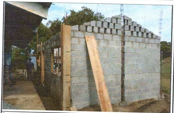
Foto 4: Así avanza la pared de la cocina al 29/11/2024
