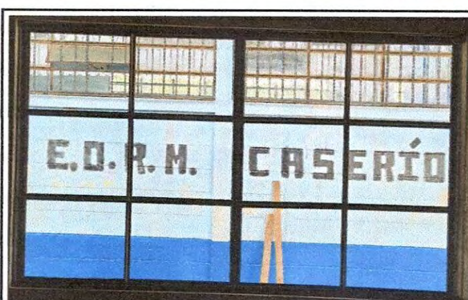
Foto 4: Finalización de colocación de ventana al módulo de cozinha 2024
